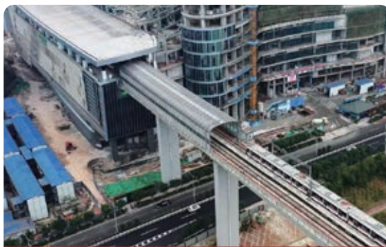
重庆轨道交通9号线一期工程项目
