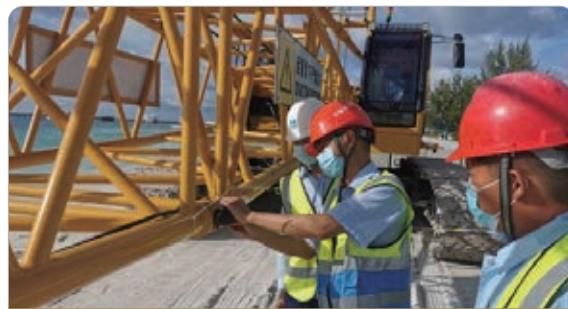
定期检查施工现场安全警示标志
