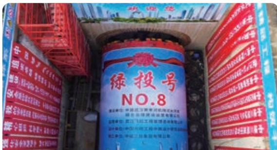
机场河截污箱涵工程盾构隧道贯通
