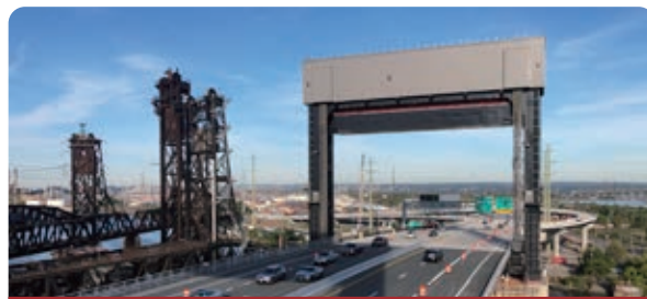
美国威潘大桥项目
