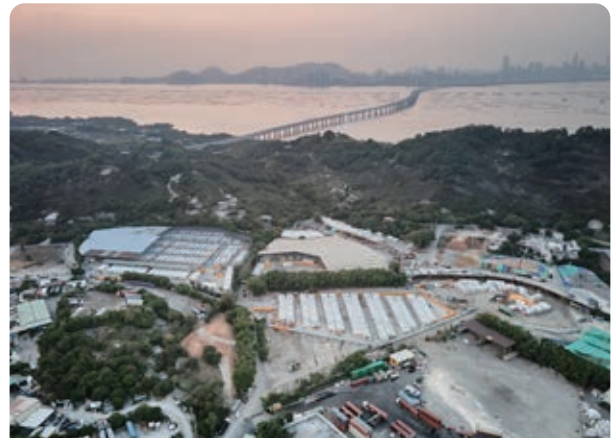
洪水桥社区方舱医院项目
