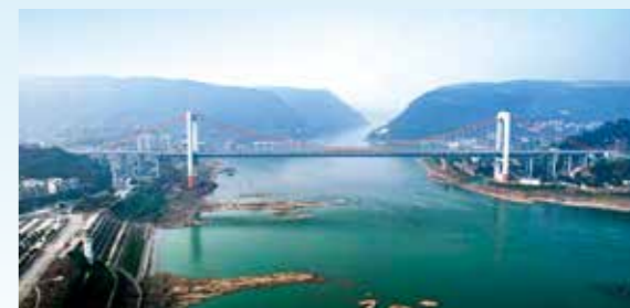
重庆郭家沱长江大桥项目
