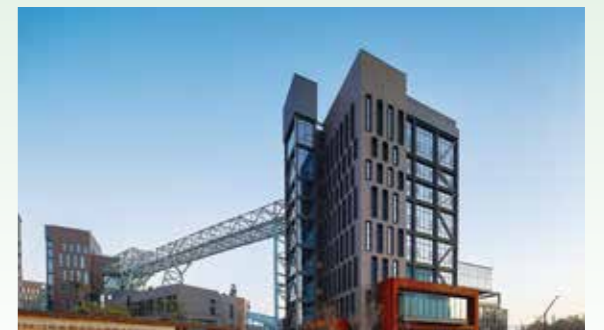
首钢冬奥组委指挥部调度中心
