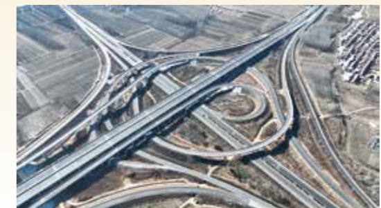
京秦高速遵化至迁安段项目
