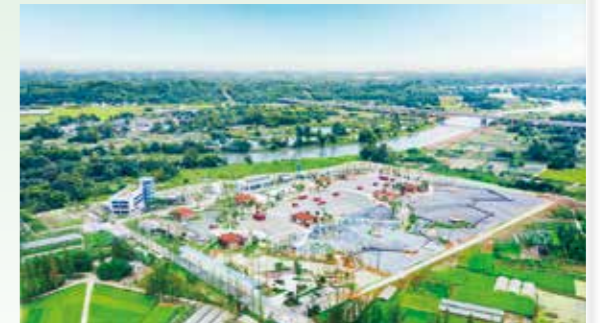
天府国际生物城污水处理厂项目
