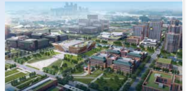
| 华南理工大学广州国际校区二期项目
