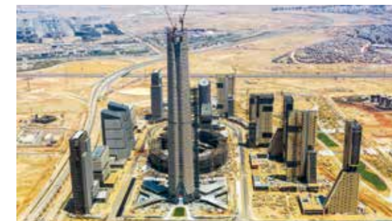
埃及新首都中央商务区项目
