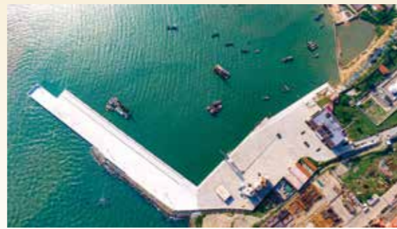
女岛港升级改造工程
