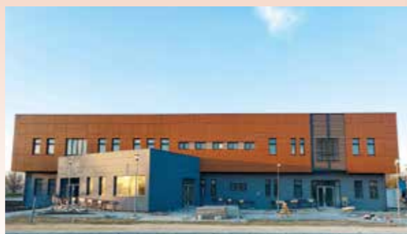
塞尔维亚诺维萨德健康中心项目
