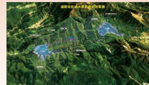
湖南安化抽水蓄能电站项目
