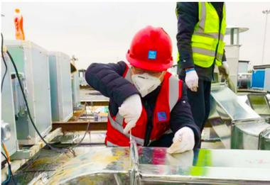
A9隔离区病房屋顶上有22个通风设备,其中10个排风,12个送风。病房的通风系统若达不到质量要求,需满足一定的风压和风量要求。简言之,病人房间里的风流出去,走廊和其他方向的风流进来,换作技术指标,缓冲间风压减隔病房的风压差值要达到5帕以上。
