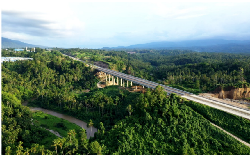
近日,由中建路桥承建的印尼美娜多高速公路项目正式竣工,即将通车试运行。该项目连接万隆老市和比通港,是北苏拉威西省6大国家战略项目之一。(孔斌)
