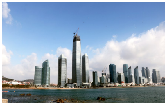
近日,中建安装参建的青岛海天中心项目开启复工复产加速模式,安装工作正在有序推进。(赵甜)
