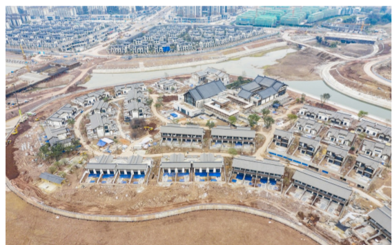
近日,中建一局西南公司履约的重庆文旅城酒店群项目主体结构全面封顶。(王丹)
