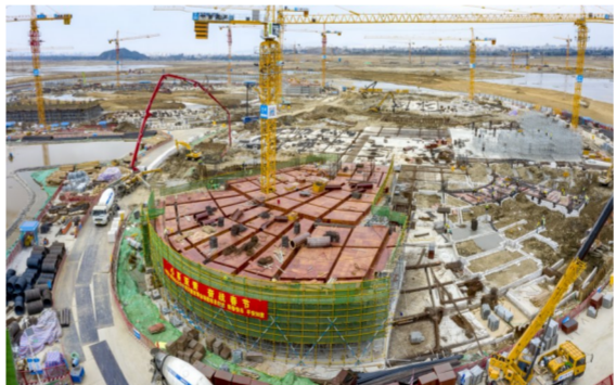
近日,中建八局南方公司汕头大学东校区暨亚青运动会场馆项目吹响复工复产“冲锋号”。(易朕)
