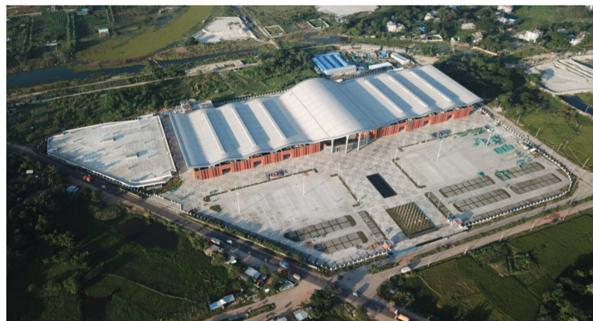
近日，中国建筑承建的援孟加拉国孟中友谊展览中心项目顺利完成竣工验收，验收结果评定为“优良”。(卢丽丽、陈诚)
