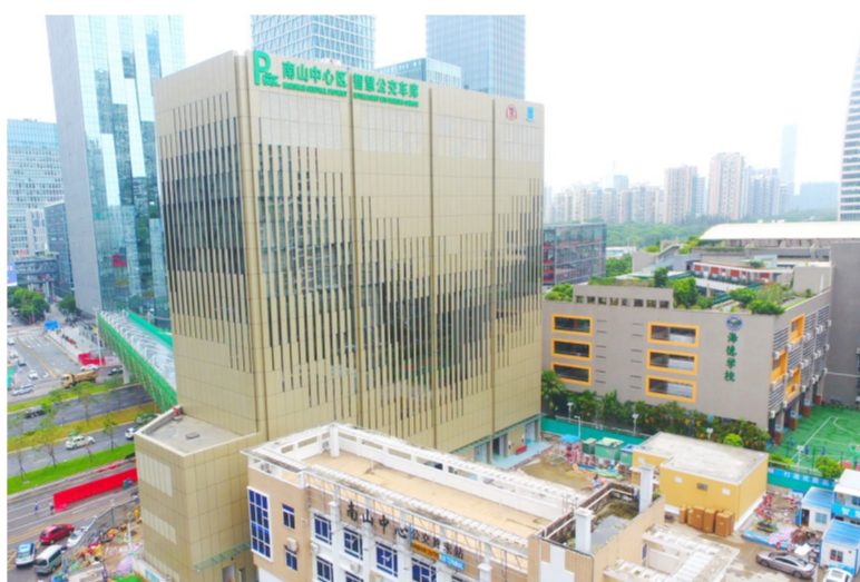
6月30日,中建科工承建的深圳南山中心区新能源公交立体车库项目完工。这是国内首个集停车、充电、调度于一体的新能源公交车库,建筑高度达到47米。长12米、重15吨的大型公交车可以从容入库。(吴佳龙)
