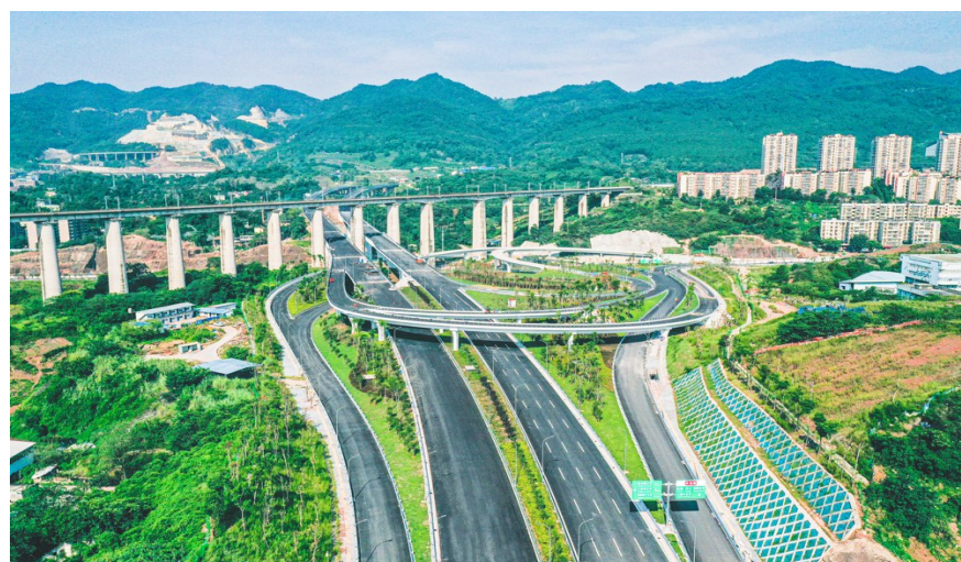
9月26日，中建五局投资建造运营的重庆市快速路二横线西段项目全面建成，项目全长14.4公里，集特大桥梁、特长隧道、集群式转体、全互通立交“四位”一体，建设过程中刷新多项世界纪录。项目通车后将进一步缓解大学城隧道、双碑隧道交通拥堵问题，推动成渝地区双城经济圈建设。(伍宣)
