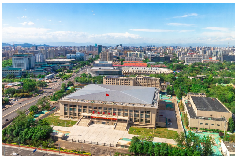
9月27日，首都体育馆园区最后一个单体工程——首体综合馆项目竣工，至此，中建八局承建的首都体育馆园区改扩建项目全面竣工。首体综合馆建筑面积1.3万平方米，内包含一块30m×61m的冰场，是国家花样滑冰项目训练备战的主要冰场。(张夏青)
