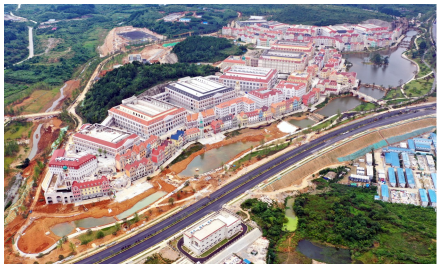
近日,中建三局一公司承建的贵安华为云数据中心项目B、C区通过竣工验收。项目位于贵州省,是集数据中心机房、配套设施及华为大学为一体的工业园区,安装存储服务器约60万台,将为170个国家的用户提供云端服务,是华为技术有限公司响应贵州建设“中国大数据之都”、在贵州落地的第一个全球云数据中心项目。(黄鹏程)
