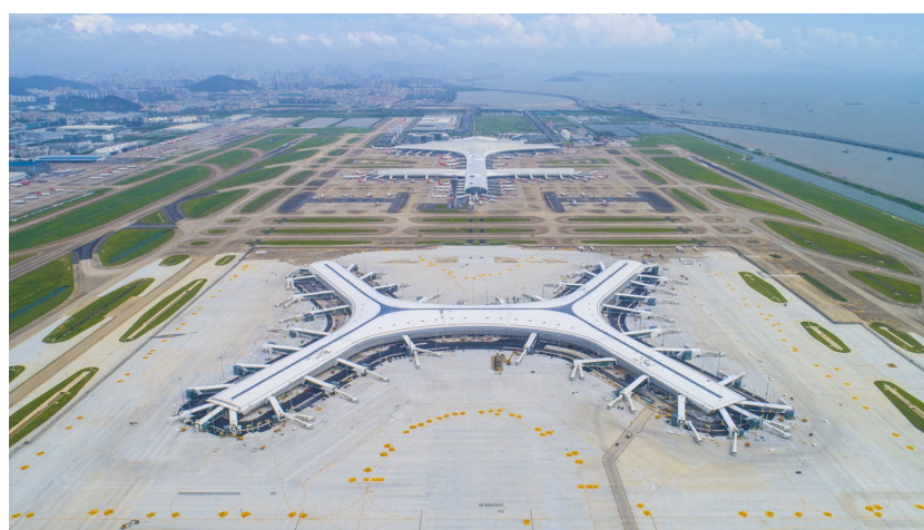
12月7日,中建股份承建的深圳机场卫星厅及其配套设施工程正式启用,项目总建筑面积23.9万平方米,整体采用“X”形蝠翼构造设计,集行李捷运、地铁换乘、旅客航空、货物集散等多功能于一体,建成后能满足2200万人次使用需求,是中国建筑在粤港澳大湾区承接的最大机场工程。(蔡茂哲)
