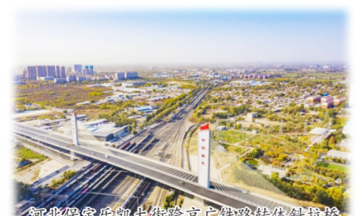
河北保定乐凯大街跨京广铁路转体斜拉桥
