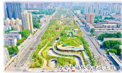
西安幸福林带建设工程
