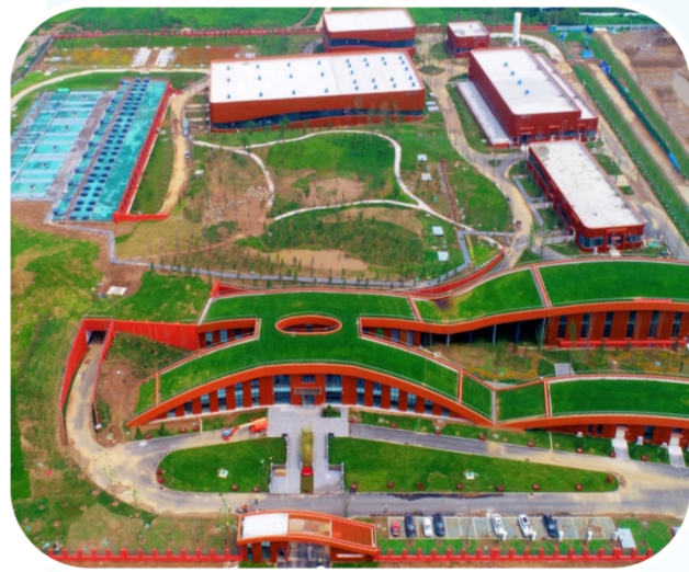
◀雄安起步区1号供水厂
