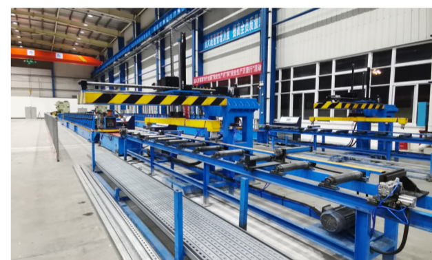
中建五局三公司加速调研成果转化,推进“中建奇配”工厂生产线上的新产品研发,助推新市场开拓。图为“中建奇配”工厂创新研发设立的成品支架、五代智慧配电箱等产品线。
