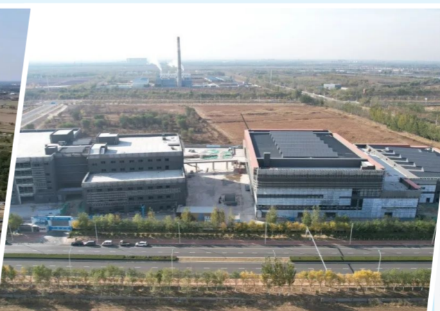
中建科工北方大区从建筑设计建造低碳化、建筑用能结构优化与提质增效三个方面开展研究与应用。图为开展装配式钢结构建筑低碳技术研究的天津06地块项目。
