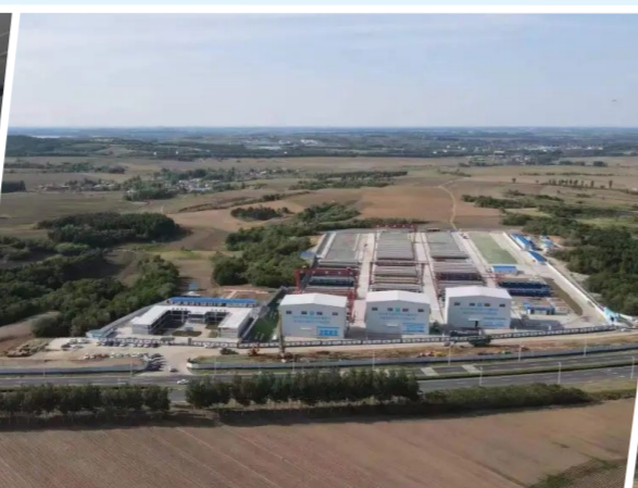
中建交通总承包公司领导班子成员赴长春9号线开展调研,重点检查项目节点完成情况、质量安全管理和项目标准化建设情况,助推项目高质量建设。
