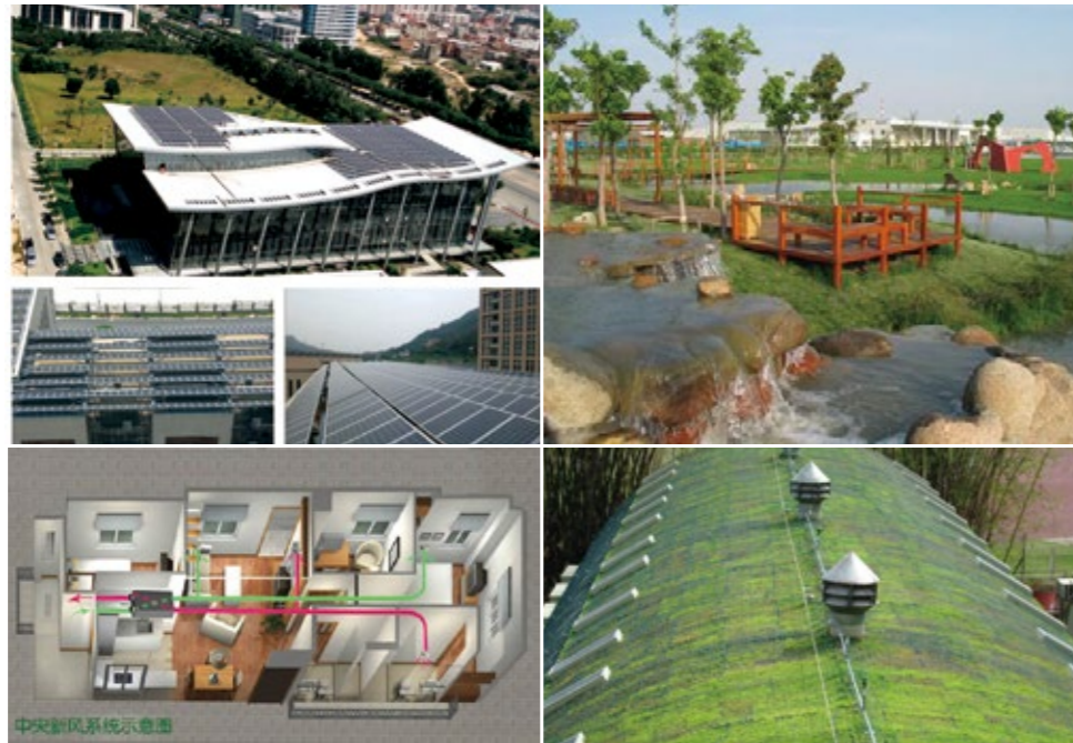
屋顶太阳能光伏发电 Roof solar photovoltaics
