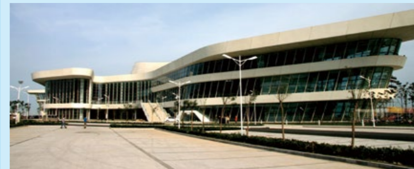
天津港国际邮轮码头客运大厦项目 The project of international cruise terminal in the Tianjin Port
