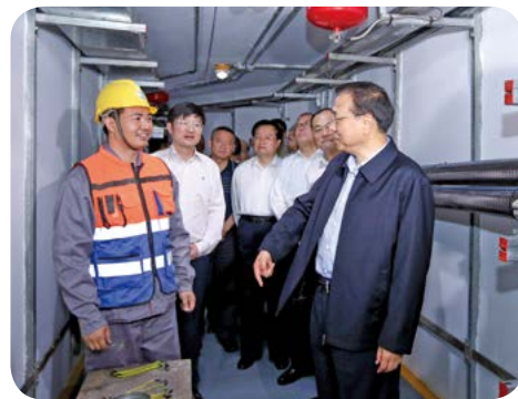
中共中央政治局常委、国务院总理李克强视察项目
