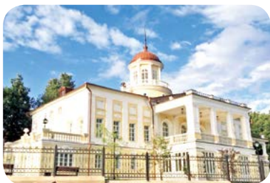
中共六大常设展览馆项目
