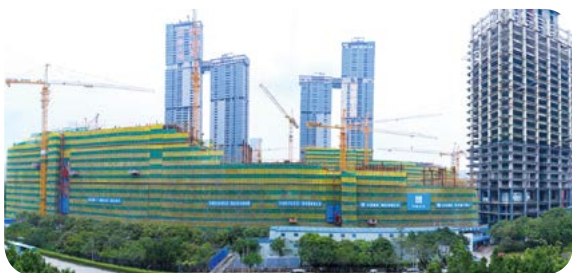
深圳深业上城项目施工现场整体外貌
