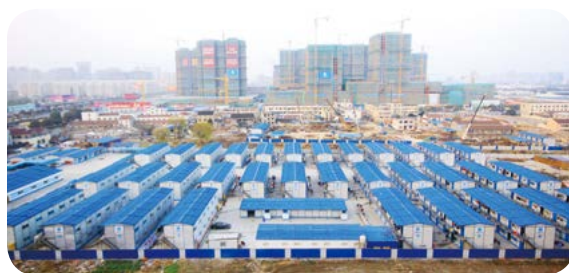
苏州吴中万达广场项目生活区
