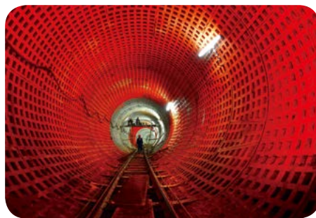
地铁施工现场
