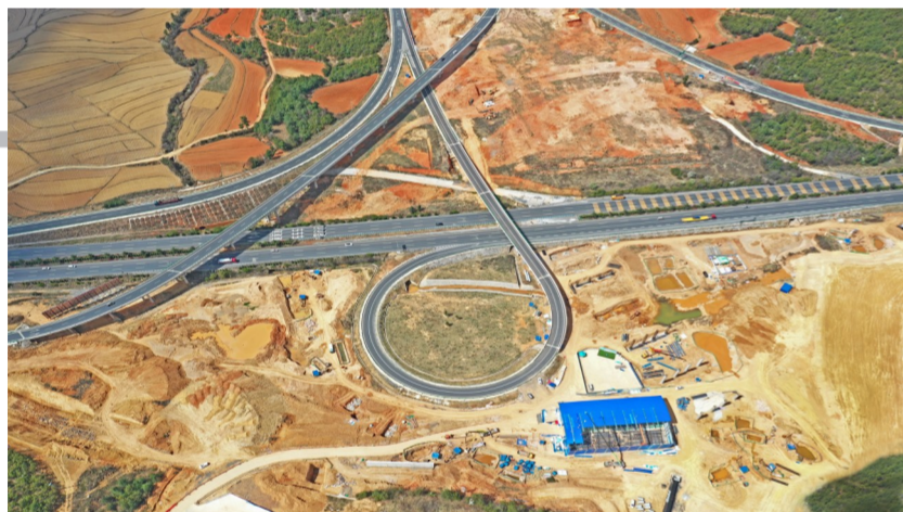
3月5日,云南省“十三五”重点建设项目——中建二局西南公司承建的三清高速二标段现场,高架桥墩正在建设,施工人员有条不紊地忙碌。项目正在进行控制性工程昌隆互通立交的修建。(赵晨、唐海洋、陈良莲)
