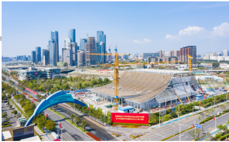
3月10日,深圳前海国际会议中心幕墙安装全面完工,披上了素有“薄纱”寓意的幕墙外衣。目前,这座由中建八局负责施工的项目,已经转入室内机电安装和精装阶段,预计今年8月投入使用。(周峰)
