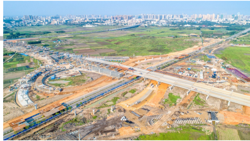
中建路桥承建的湛江大道二标项目是湛江市首条城市快速主干道——湛江大道的节点性工程。近日,该项目抢抓早抓、主动作为,坚持“防护第一”的同时成立项目生产突击队,全面掀起大干快上的建设热潮。(侯宇浩)
