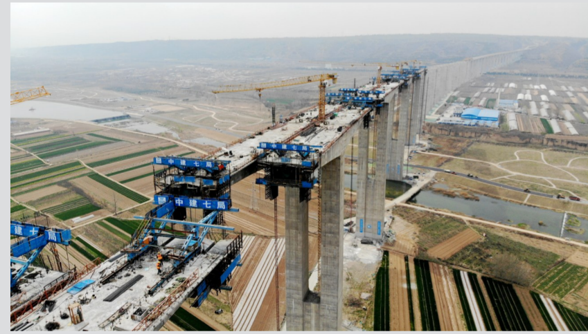
近日,由中建七局交通公司承建的河南第一高桥——三门峡市国道310南移新建工程弘农河特大桥全面复工...
