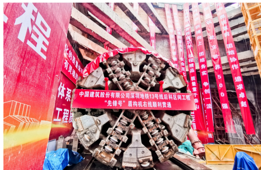
6月7日,中建股份深圳地铁13号线首条盾构区间后海站—科苑站右线顺利贯通,标志着13号线盾构掘进步入快速道。(陈荣安)
