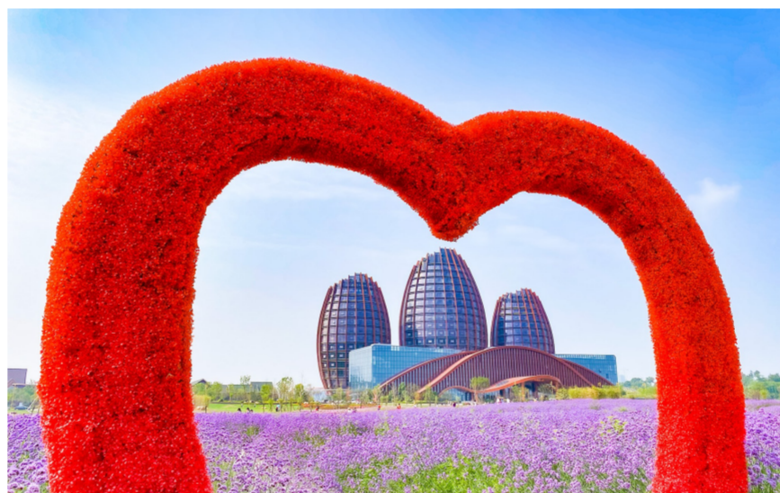
近日,中建五局投资建设的赣州南康家居小镇PPP项目顺利完成北山孵化器整体完工重大节点,将打造“天下家居第一镇”。(刘兴湘)
