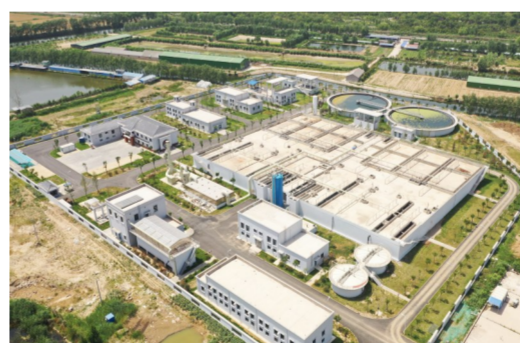
近日,由中建安装上海分公司承建的徐州大晶圆工业污水处理厂工程已顺利竣工,进入试运行阶段。(杨木)
