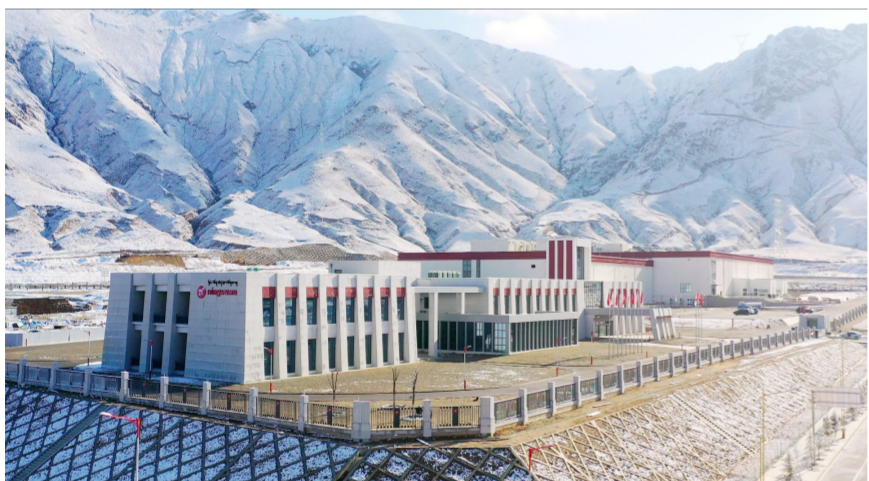
近日,中建一局五公司承建的全球海拔最高的大数据中心——西藏宁算数据中心一期项目通过竣工验收。(赵秀玉)
