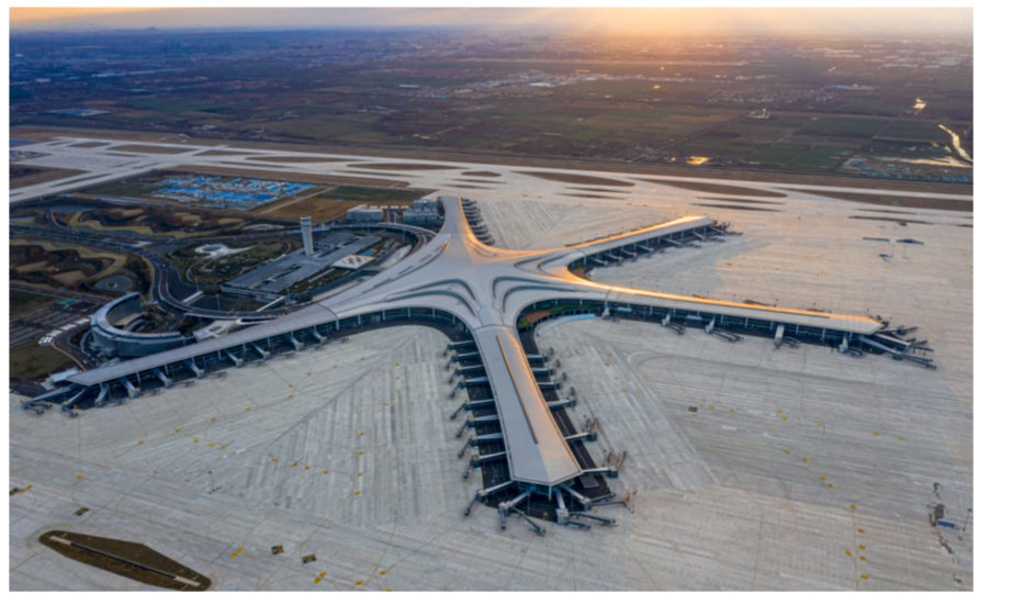
近日，中建八局四公司承建的青岛胶东国际机场项目顺利通过行业验收。未来可满足年旅客吞吐量3500万人次、货邮吞吐量50万吨的保障需求。(陈佳昊)
