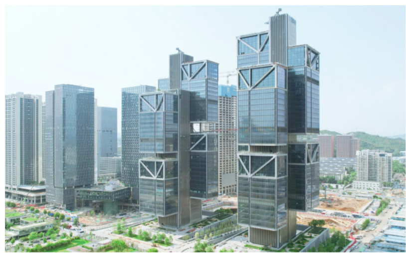
近日,中建四局承建的大疆天空之城项目通过竣工验收。项目位于深圳市南山区,由东西两塔组成,其中东塔高211.6米、西塔高193.1米。项目作为大疆创新科技有限公司的全球总部基地,建成后将成为无人企业总部集聚、研发创新、运营服务和综合配套服务四大功能区,成为深圳又一地标建筑。(翁铨煌)
