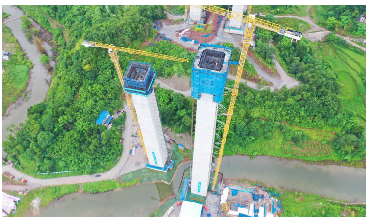
近日,中建三局承建的重庆芦沟河特大桥最高墩封顶。大桥长2188米,主桥单墩长1092米,最高桥墩墩7号墩高达192米,组合参数规模在连续刚构组合桥型中位居亚洲第一。建设过程使用自主研发的新一代“造墩机”,最快可达4天一墩,单日产能突破1.13米。(孔祥宇、毕玉红)
