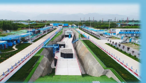
西安地下综合管廊项目
