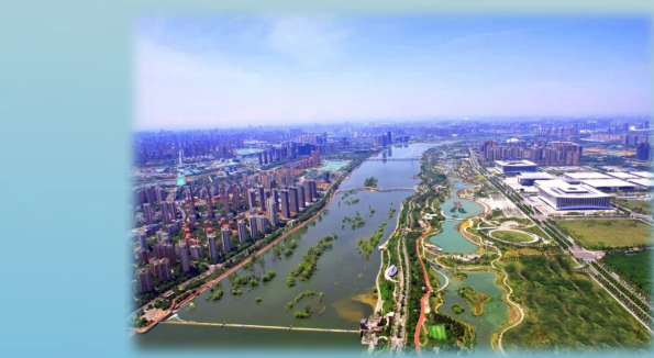
西安浐灞生态区灞河右岸片区提升改造项目
