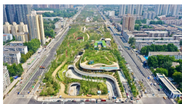
西安幸福林带建设工程
