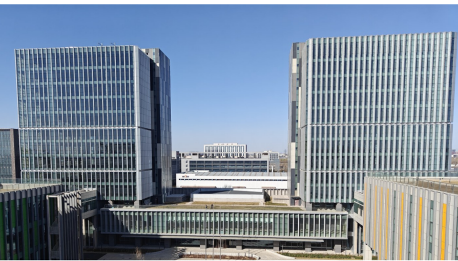
中建七局承建的中国石化(亦庄)智能制造研发生产基地项目主体结构和外部装饰工程通过竣工验收。中国石化(亦庄)智能制造研发生产基地项目总建筑面积约11万平方米,是中国石化与北京经济技术开发区贯彻落实京津冀一体化战略、服务首都功能新定位而开展的一项重要合作项目。该项目建成后主要从事智能化节能加油站、工业防爆机器人、智能传感器、智能防爆终端、工业互联网平台(流程工业智能制造生态平台)等产品的研发、生产,进一步实现提质增效。(刘维金)
