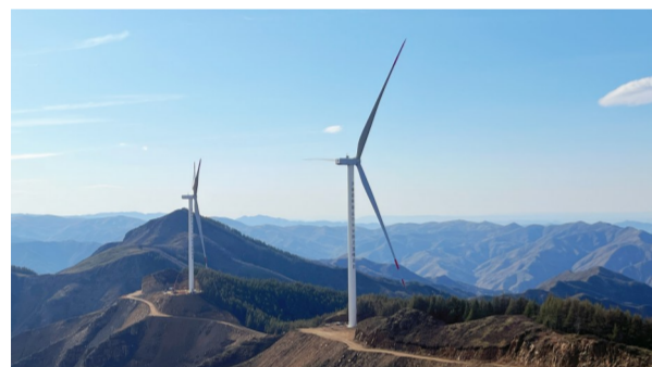
山西天镇县环翠山70兆瓦风电PC项目
