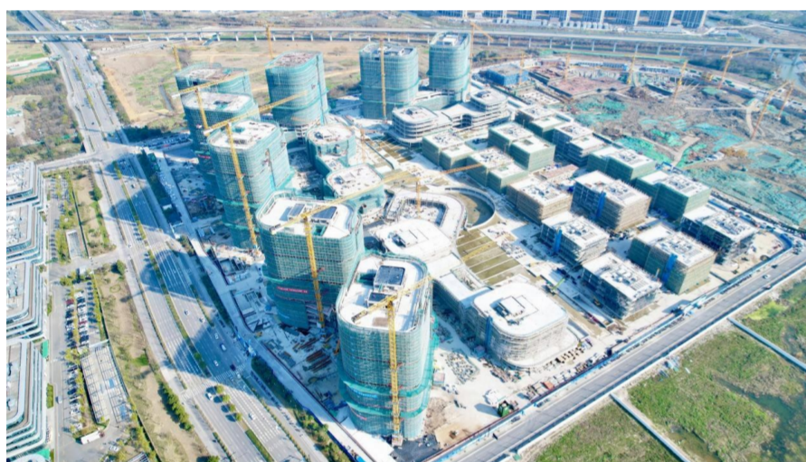
中建一局建设发展公司承建的杭州菜鸟西湖云谷产业园项目全面封顶,进入装修和幕墙施工阶段。项目总建筑面积约62万平方米,共计28栋单体建筑,施工过程中项目团队应用BIM5D技术,使用TEKLA软件进行钢构件分段深化、节点优化和方案模拟,并根据现场进度动态转化,提高施工精确度。项目建成后,将成为具有自主知识产权、掌握核心技术的智能化研发、生产及检测中心,助力中国云计算和大数据技术发源地及核心产业带建设。(品萱)
