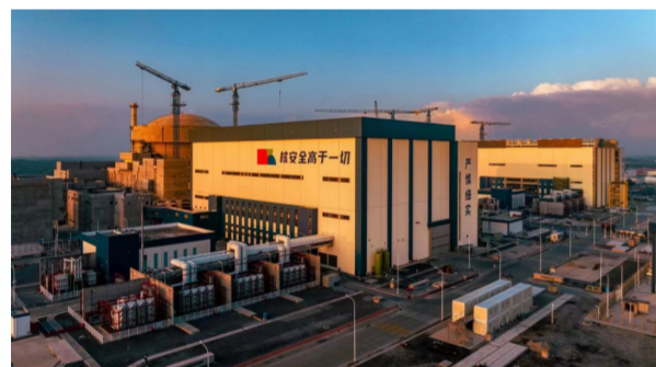
广西防城港核电站
