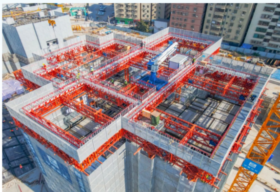
中建三局研发的住宅造楼机正在作业
